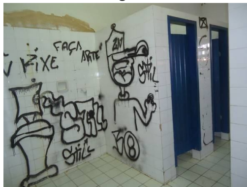
Figura 24 - Sanitário da EE Pe. José Biezinger
