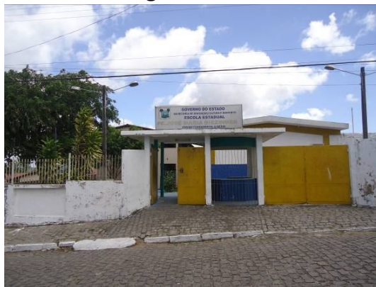
Figura 27 - Acesso à EE Pe. José Biezinger
