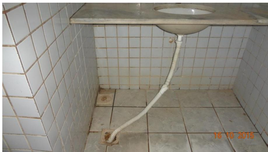
**Figura 5 – Ligação de esgoto improvisada (E. E. Alte. Tamandaré – Extremoz)**
