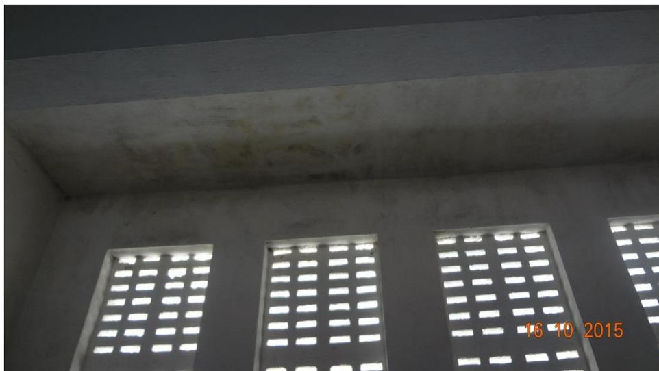
**Figura 4 – Infiltração em laje (E.E. Alte. Tamandaré – Extremoz)**
