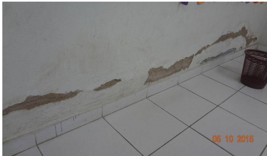
**Figura 3 - Parede da sala de aula com sinais de infiltração (E.M. Manoel Raimundo)**
