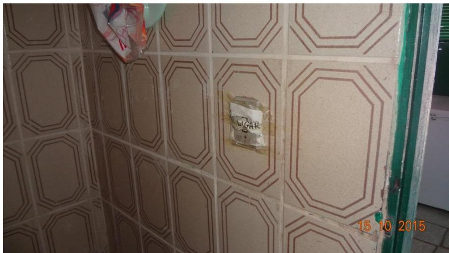
**Figura 6 – Interruptor de luz com risco de choque elétrico (E. M. Jorge Câmara – Extremoz)**
