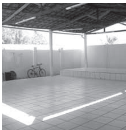
A tesoura de madeira estava sem estabilidade, comprometendo a estrutura
