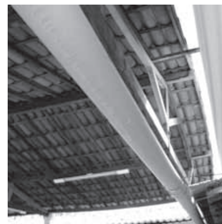
A tesoura de madeira estava sem estabilidade, comprometendo a estrutura
