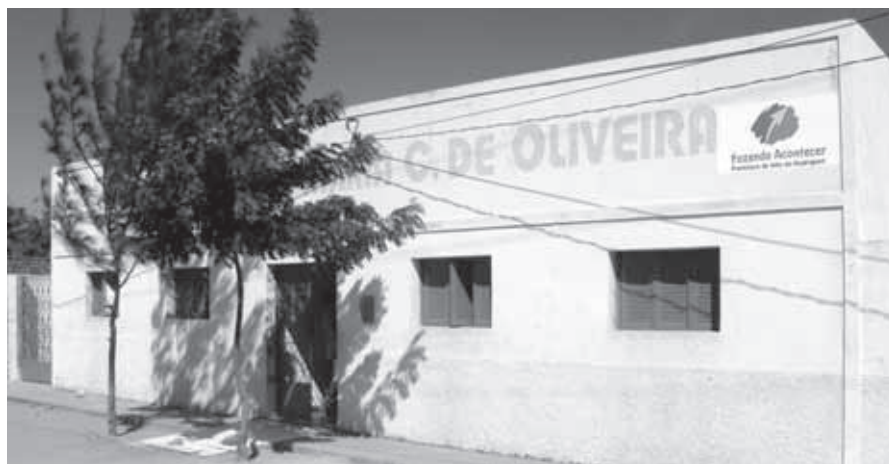
Apesar de recente, a obra do galpão da escola apresentou vários problemas
